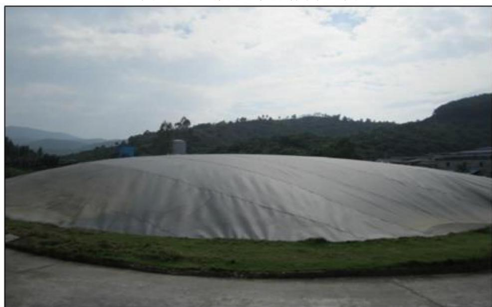
图 3.2-9 建成后的黑膜沼气池示意图
