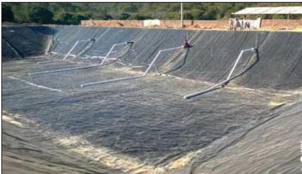
图 3.2-7 黑膜沼气池内部示意图
